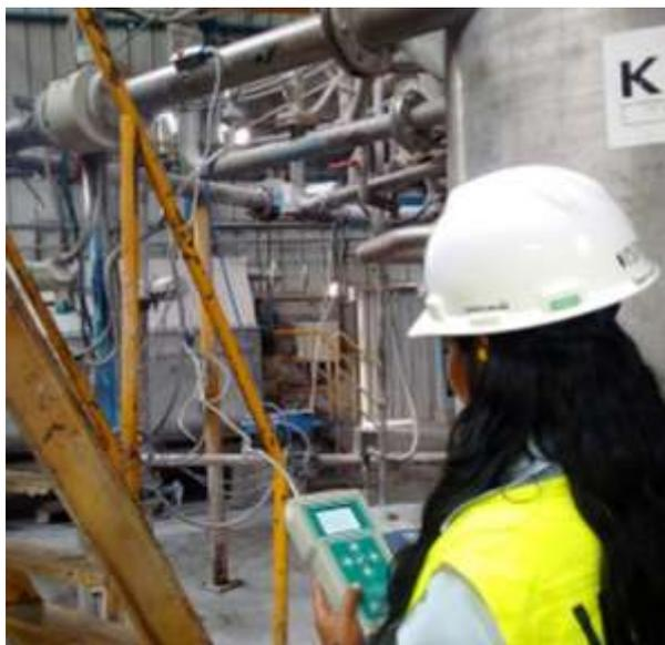
PDFM 5.1 - это портативный доплеровский расходомер, который просто прикрепляется к внешней стороне трубы для измерения расхода в трубе. Технология Доплера означает, что она подходит для грязных или сложных жидкостей, содержащих пузырьки или твердые частицы, таких как сточные воды, шламы, шлам, химические вещества, вязкие жидкости и абразивы.
